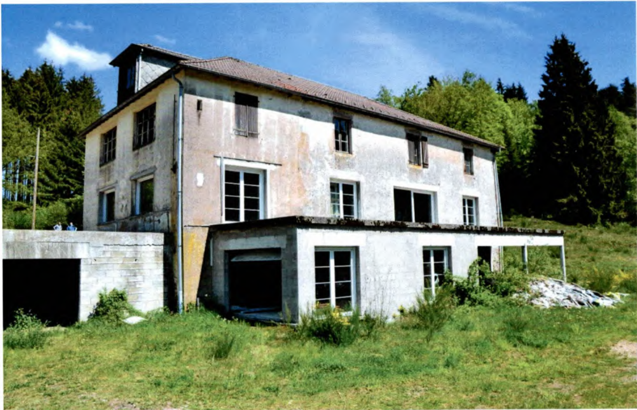
Façade arrière avec terrasse couverte
