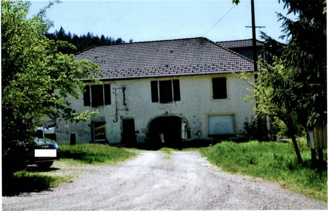
Façade principale de la maison (vue depuis la route Départementale n°3)
