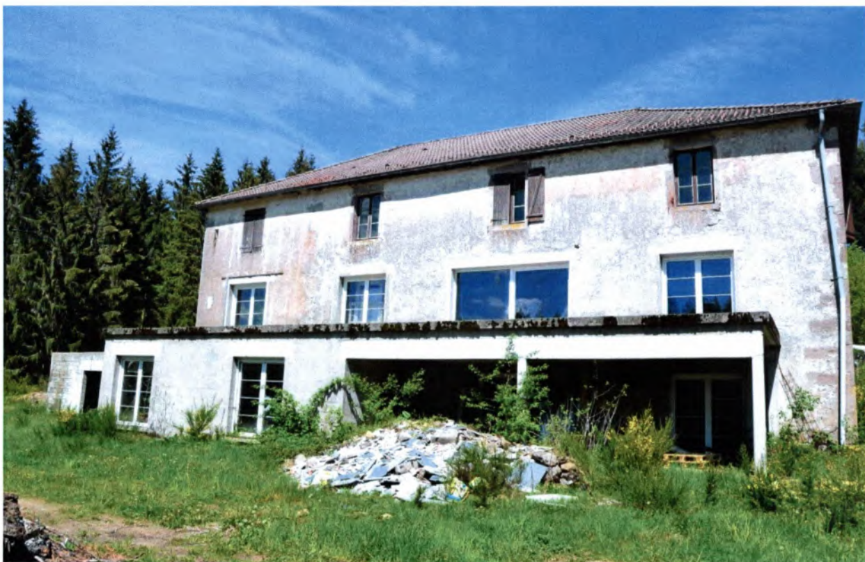
Façade arrière avec terrasse couverte
