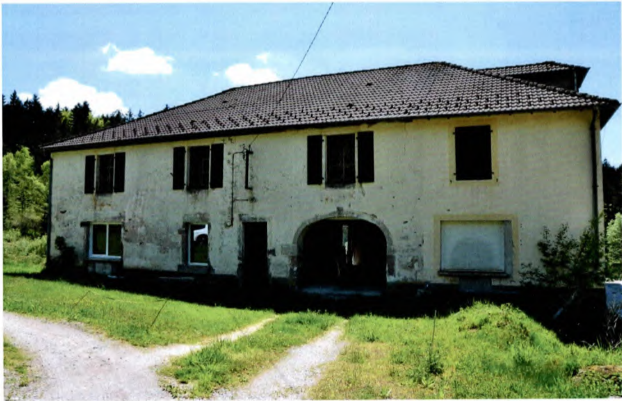
Façade principale de la maison
