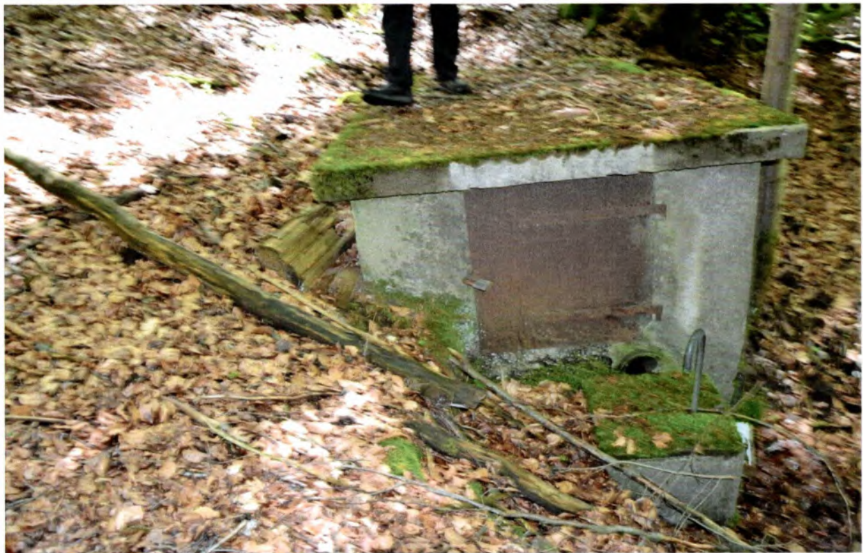
Zone boisée marécageuse (réservoir d'eau)
